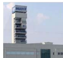
Testy długości instalacji
